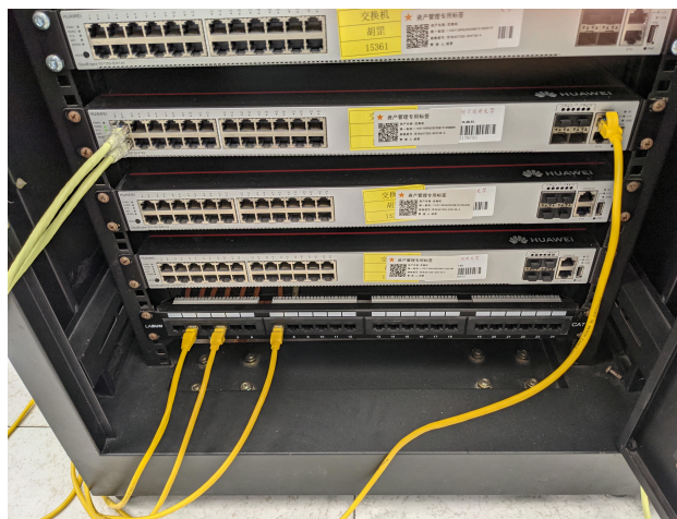
Figure 5: 机柜正面接线图
